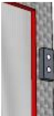
Il controllo accessi installato nei pressi dell'ascensore abilita la chiamata dell'ascensore e contemporaneamente disattiva la barriera a tenda sulle scale. Se non si disattiva la protezione non è possibile usufruire dell'ascensore e non si possono salire le scale senza che non venga segnalato con un avviso sonoro-luminoso
